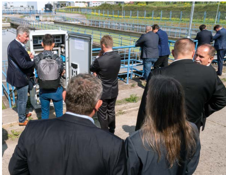
Účastníci si prohlédli současné varianty využití vyrobené elektrické energie prostřednictvím bateriového úložiště nebo fázování elektřiny přímo do rozvodné sítě.
