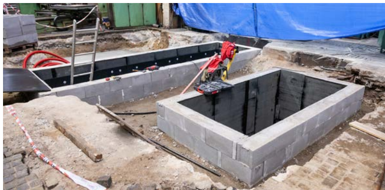
Příprava základových konstrukcí pro tři obrážečky HOV25, HOV 63 a STSY 1400, které se přemísťují z haly 4 na halu 5. Hodnota základových konstrukcí činí celkem 1 110 tisíc korun.
