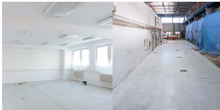
Stavební úpravy nových prostor pro Elektrodlínu a Elektroprojekci na hale 59 se blíží do finále. Elektrodlína bude umístěna v 1. lodi haly a Elektroprojekce ve 2. NP přístavku.
