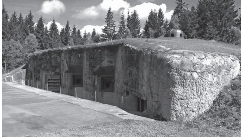
Dnes již historický pohled na stav objektu Mýtina tvrze Hanička před zahájením rekonstrukčních stavebních úprav. První dvě střelny jsou původní, poslední střelna byla v akci „Kahan“ přebudována na ocelové protiatomové dveře.
