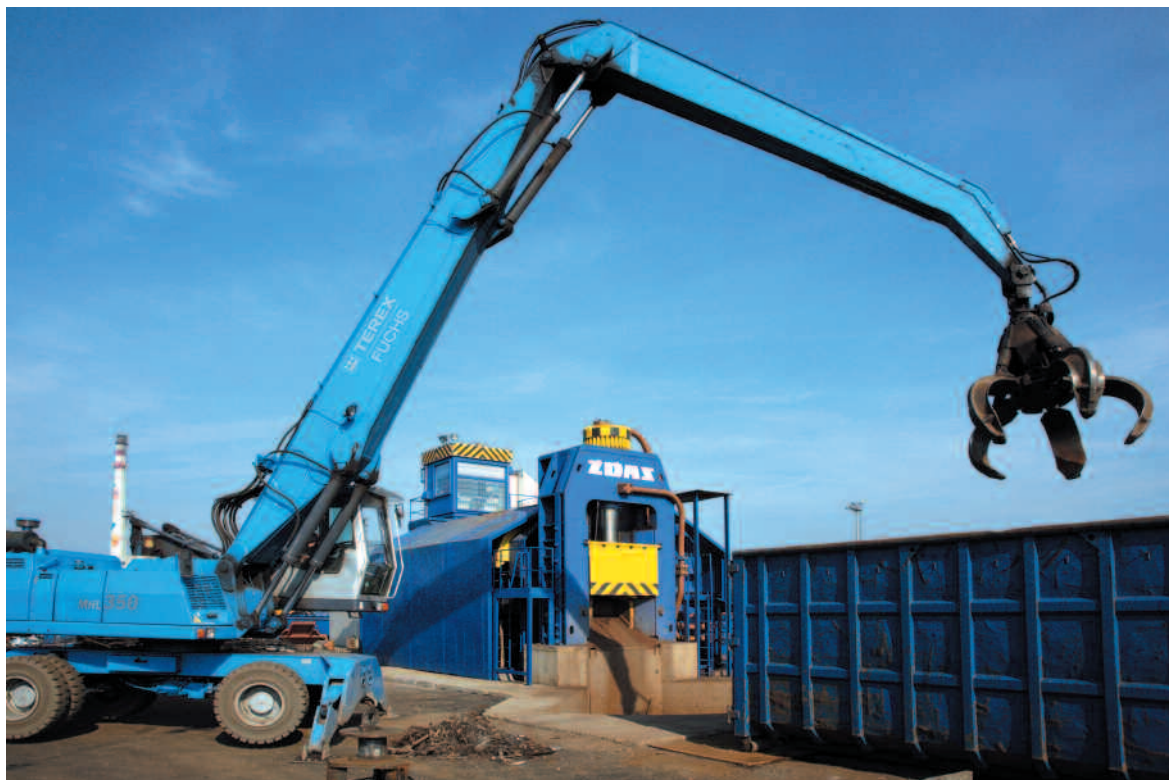
Рабочий пункт с гидравлическими ножницами CNS-PVM
