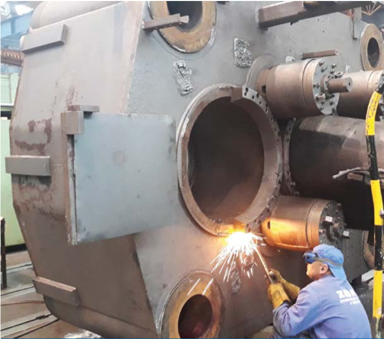
U lisu MANNESMANN MEER 1500 bylo nutné kompletně demontovat horní příčník, který byl opraven v provozu společnosti ŽĐAS.
