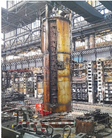
Demontáž ocelového tubusu pece č. 1
